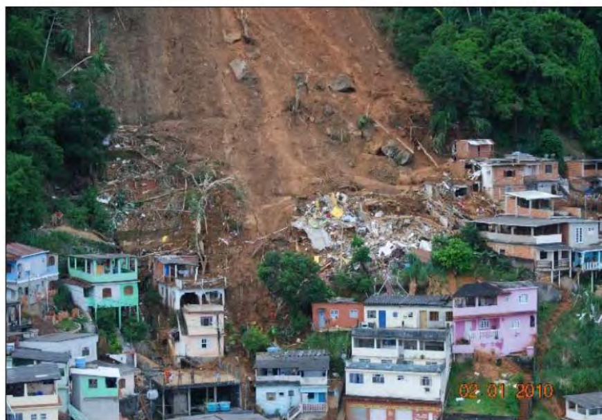
Figura 3.1-29: Escorregamento registrado no Morro da Carioca, no centro do município de Angra dos Reis. Fonte: Ribeiro (2014).
