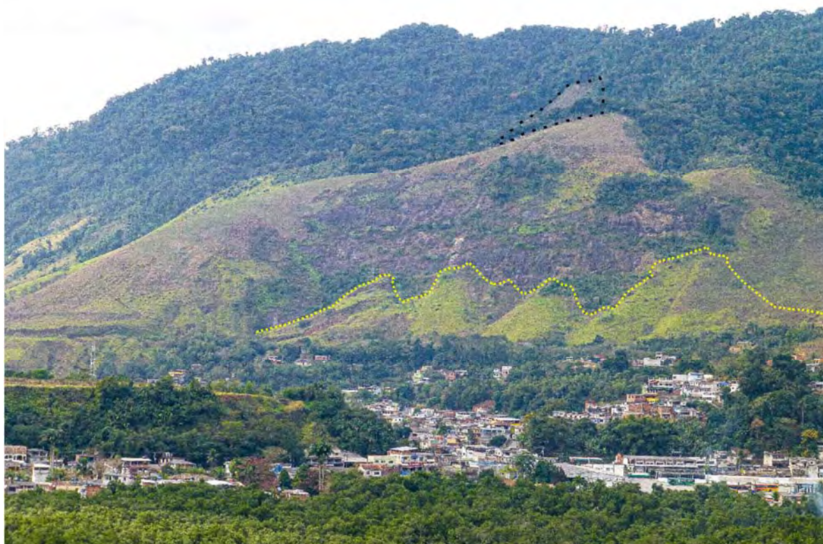
Figura 3.1-27: No sopé da encosta, bairro de Areal. No terço inferior da encosta, à montante da área ocupada, depósitos de tálus e colúvio (amarelo pontilhado). No terço médio, face rochosa exposta pelos escorregamentos de 2002. No terço superior (preto pontilhado), depósito de material inconsolidado. Fotografia de João P.C. Araújo (julho de 2019)
