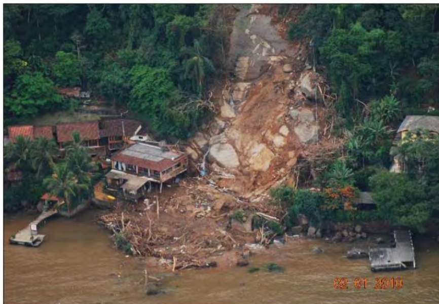
Figura 3.1-28: Escorregamento translacional atinge a Pousada Sankay, localizada na Enseada do Bananal em Ilha Grande. O evento ocorreu na noite de réveillon. Fonte: Ribeiro (2014).
